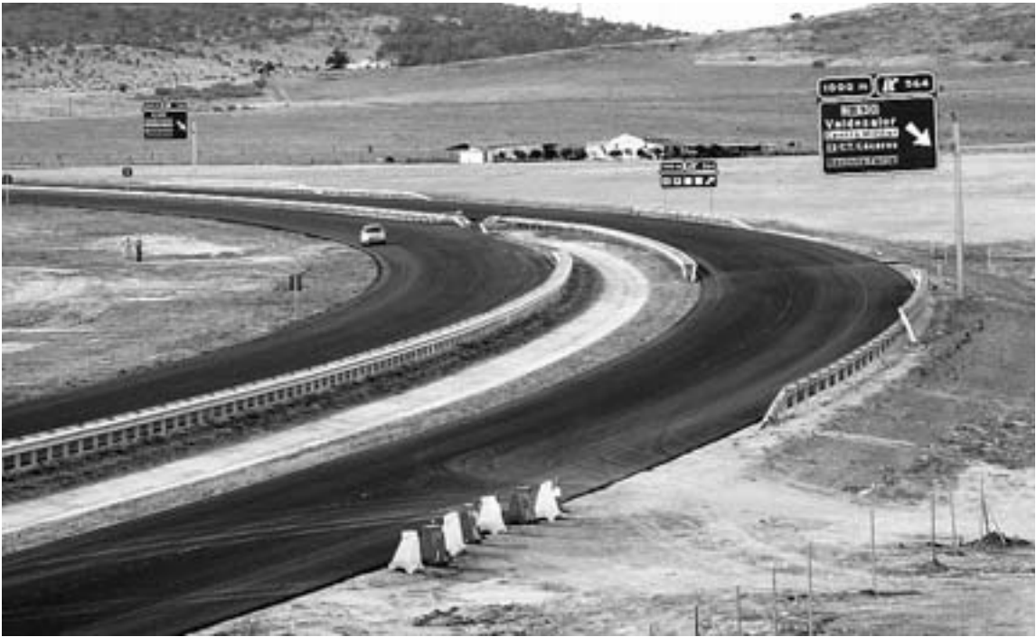
Tramo de la A-66 entre Cáceres y Aldea del Cano, casi acabado a su paso por Valdesalor. / ALTAMIRANO
