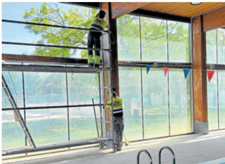
Trabajos en la piscina climatizada. CEDIDA
