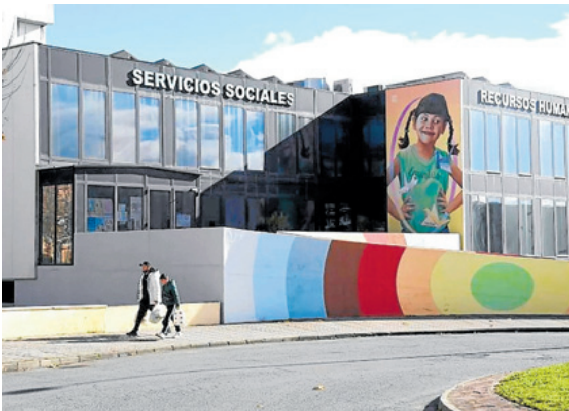
Fachada principal del edificio de Servicios Sociales del Ayuntamiento de Plasencia. HOY
