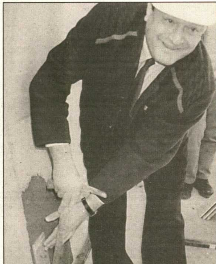
El alcalde de Villafranca coloca la primera plaqueta en los muros del canal del arroyo Bonhabal. (ORTIZ)
