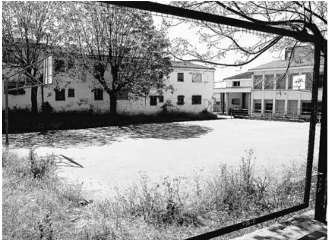
La pista, que está junto al edificio cedido a la asociación, se encuentra deteriorada. / EMILIO PIÑERO
