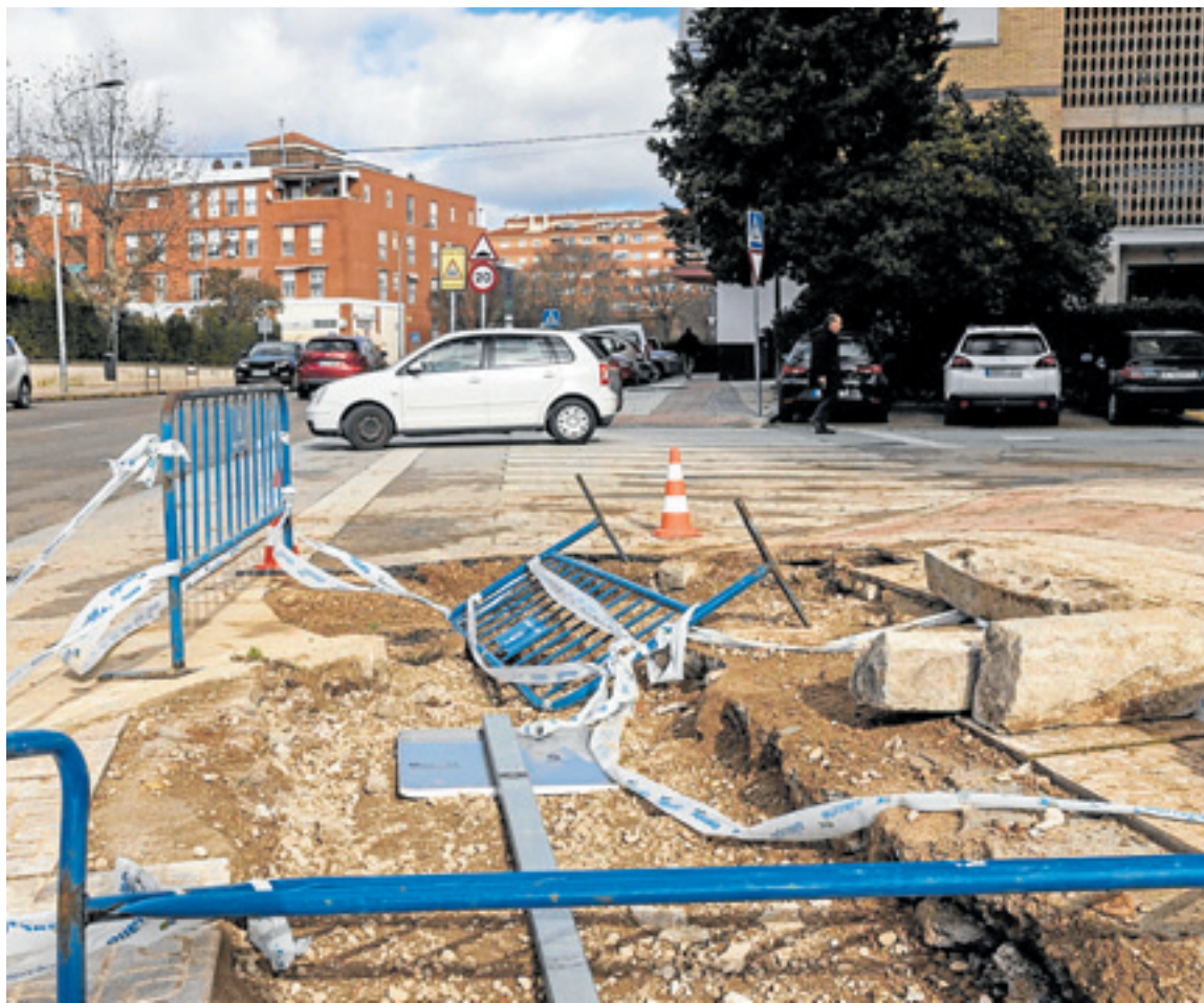
Vallas en una de las zanjas abiertas en la avenida Augusto Vázquez. ÁNGEL MÁRQUEZ
