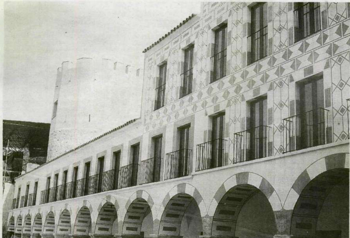
CASI 3 AÑOS CERRADO. El edificio de la futura escuela lleva casi tres años terminado y sin usar. / HOY
