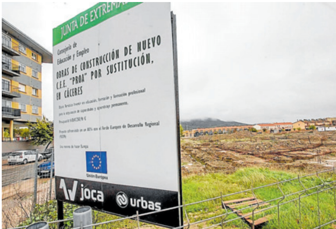
La obra del nuevo colegio de educación especial lleva parada desde noviembre de 2022. HOY
