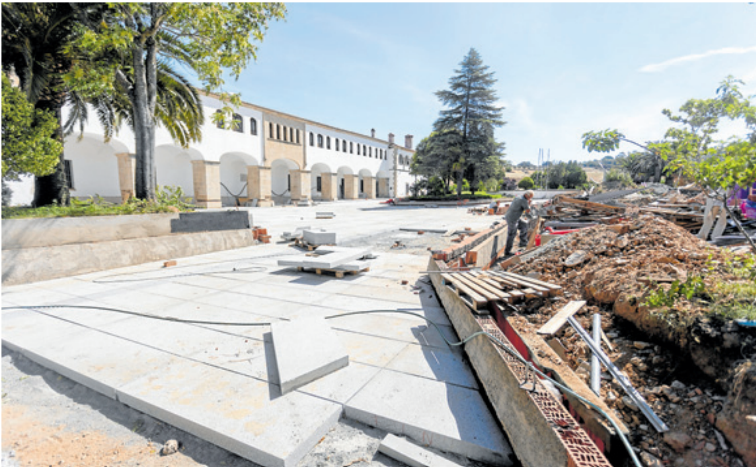
Obras exteriores en el complejo cultural San Francisco de Cáceres. JORGE REY
