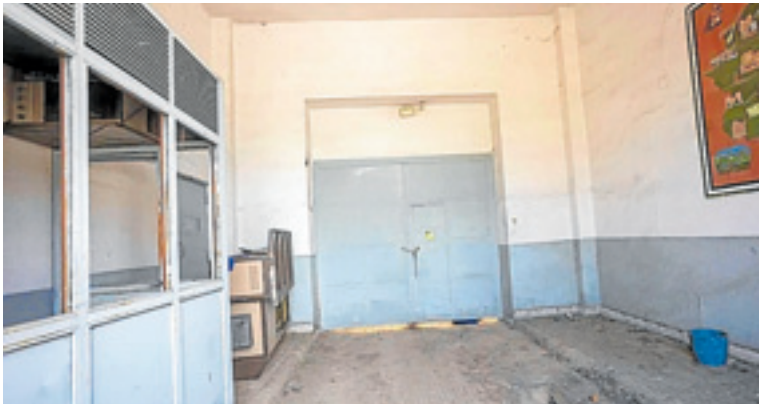
El edificio se encuentra cerrado y su clausura definitiva se produjo en 2009. J.R.
