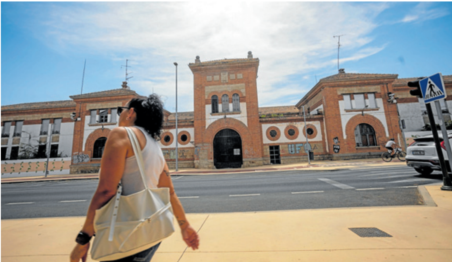
La cárcel vieja, cuya primera piedra se colocó en 1934, está situada en la avenida Héroes de Baler de Cáceres. JORGE REY
