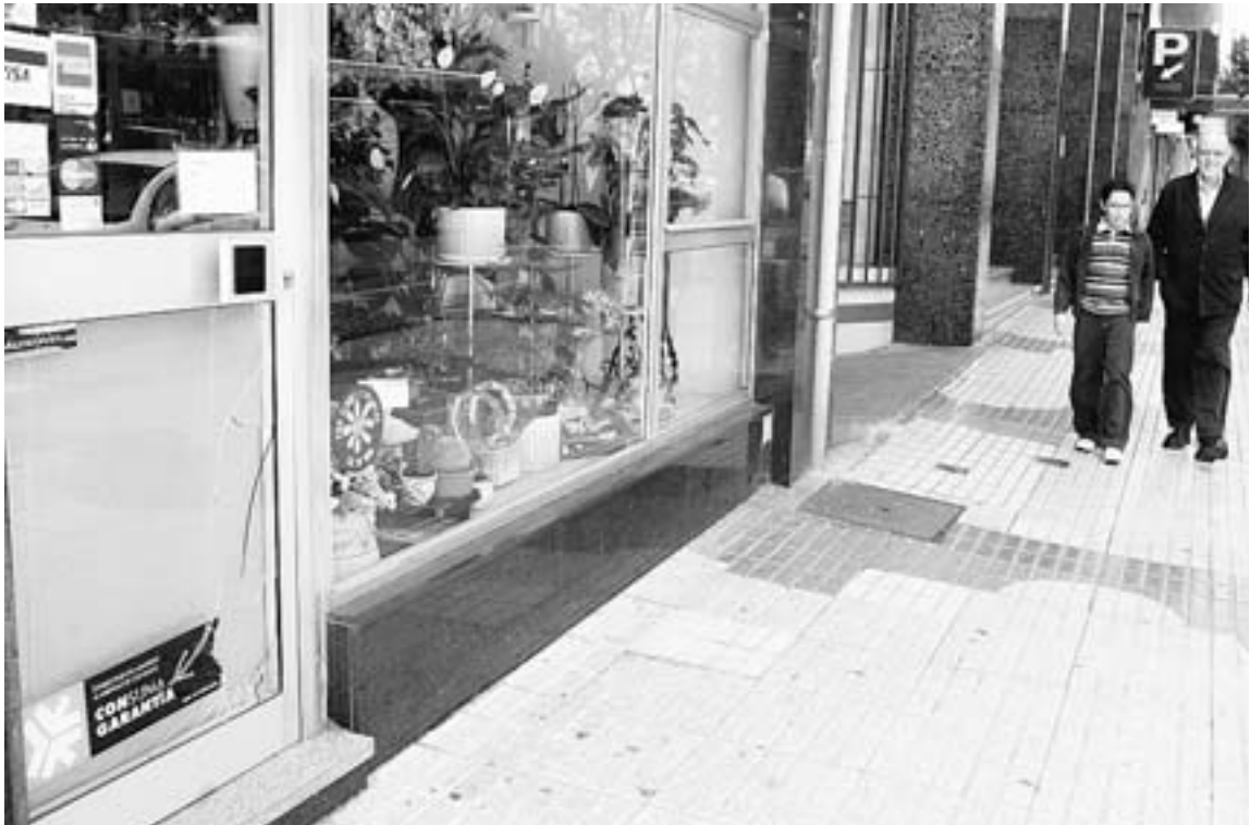
La floristería de la avenida de España resultó dañada y sus autores denunciados. / LORENZO CORDERO
