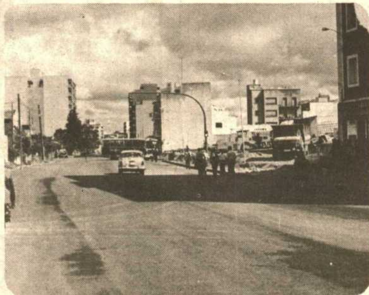
Carretera o avenida de Valverde. Obras públicas ha ensanchado considerablemente esta vía, pero ¿se construirán las aceras? El peatón tiene que circular por la calzada, como podemos ver en esta fotografía captada por Emilio
