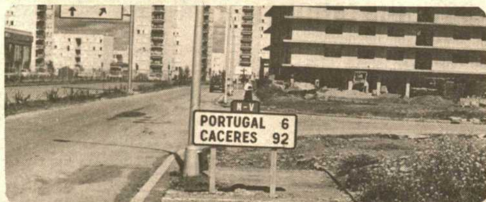
El Instituto Nacional de Urbanización está construyendo aceras en la calzada de servicio del Polígono de Santa Marina. Serán las únicas de que va a disponer el peatón a lo largo de la «Autopista», pero en ellas se han colocado carteles de señalización que obstaculizan el paso. — (Foto Emilio.)
