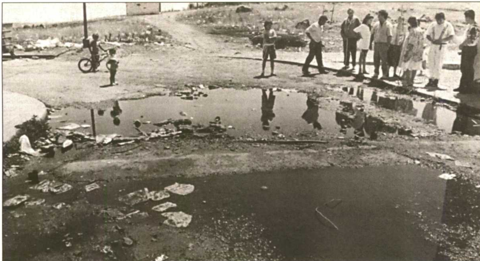
Situación que presentaba ayer la calle Aljucén en la barriada de Las Cuestas de Orinaza. / Foto: SANTI
