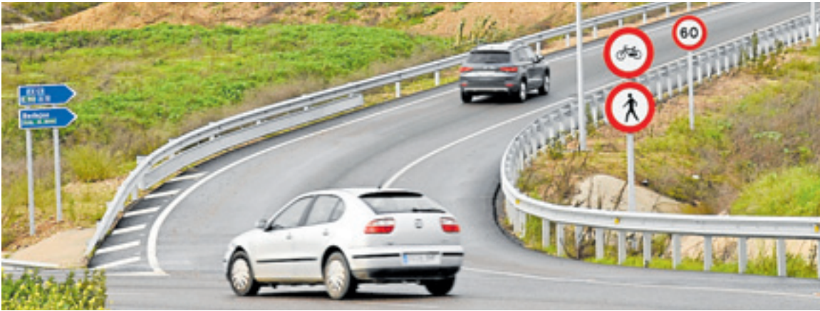
Conexión de la carretera de Olivenza con el puente 25 de abril, único tramo de la ronda sur construido. HOY
