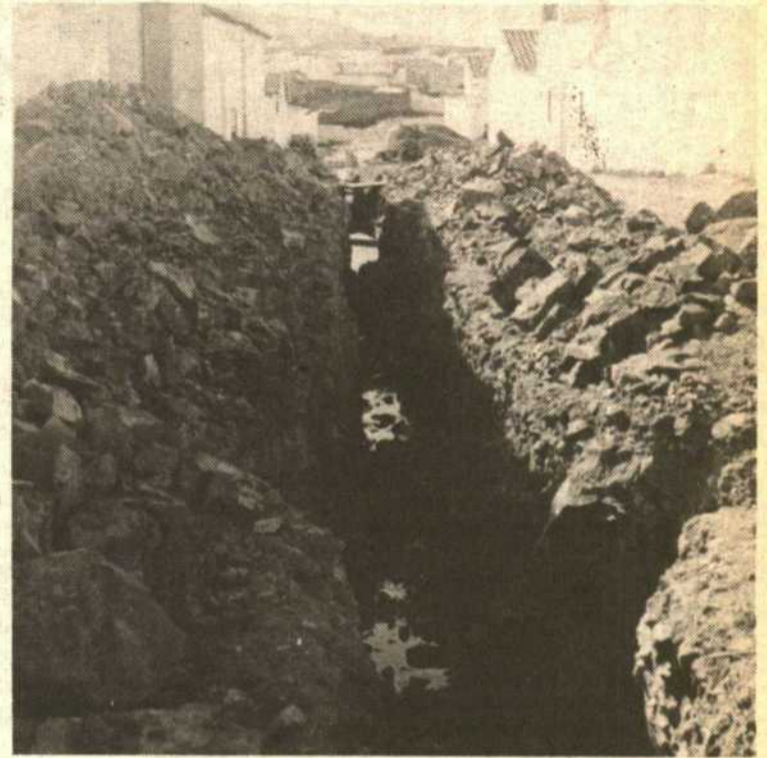
Zanja abierta para colocación de las tuberías del saneamiento.— (Foto Venegas.)
