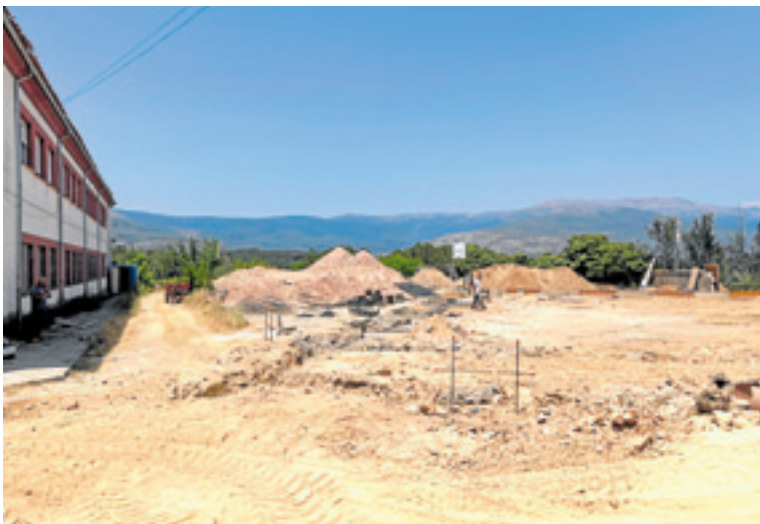
Las obras de la edificación de la nave multiusos. M. D. CRUZ
