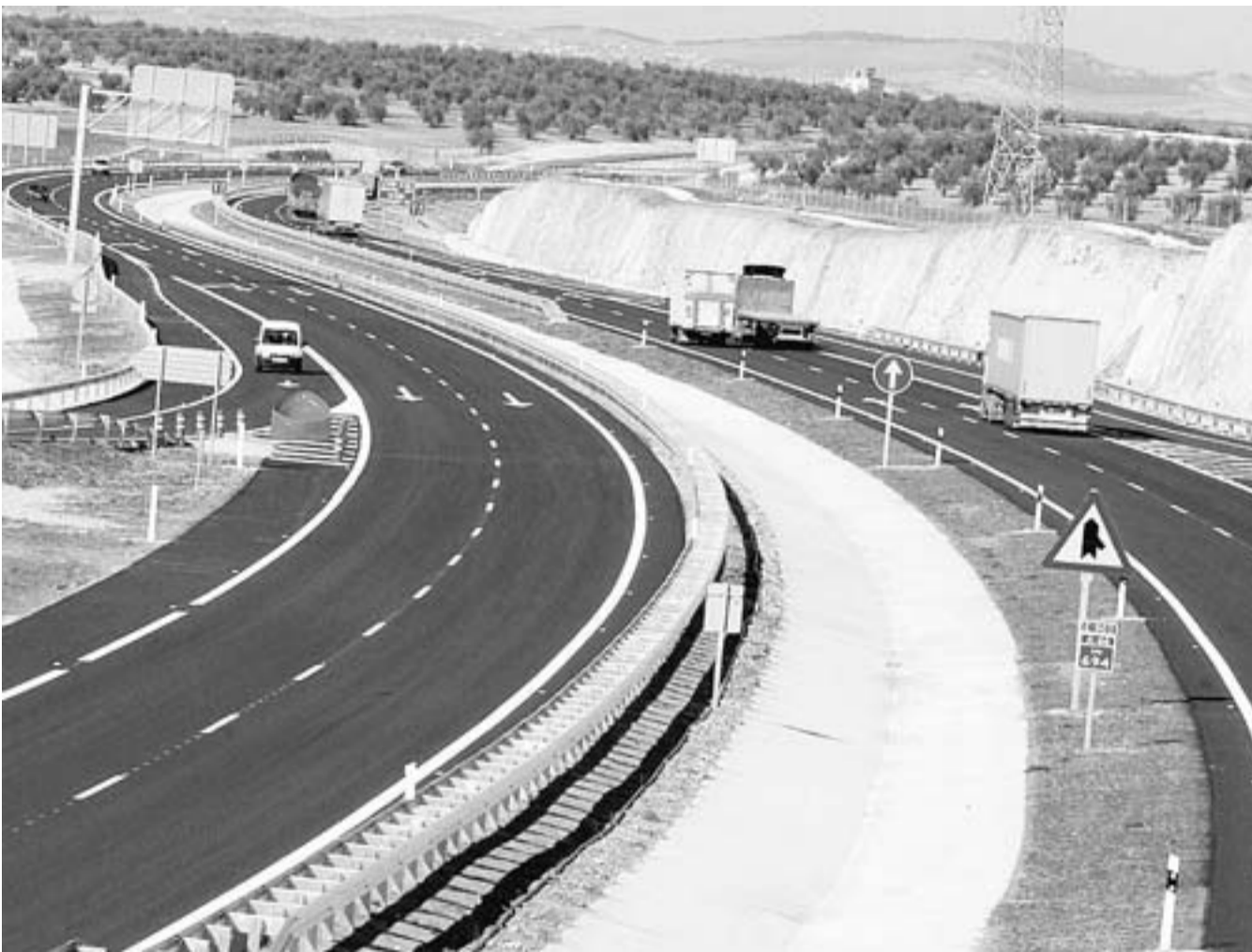
INAUGURADO. El tramo Zafra-Fuente de Cantos, de 12,4 kilómetros, ya puede ser transitado. / EMILIO PIÑERO
