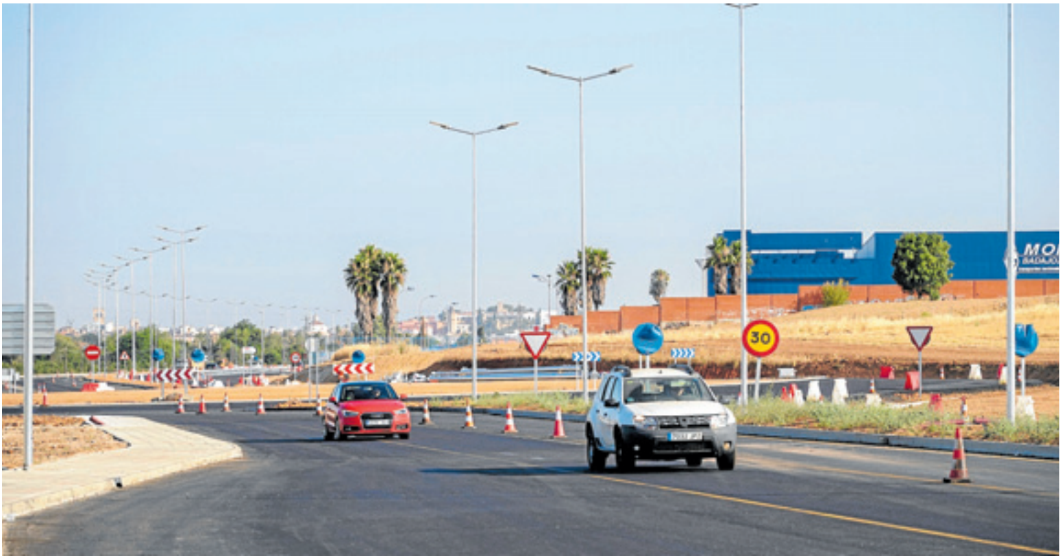
Salida de Badajoz por la carretera de Sevilla, con farolas, aceras y rotondas.
