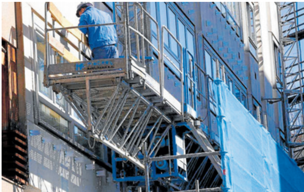
Obra en la fachada de un edificio en una imagen de archivo. HOY
