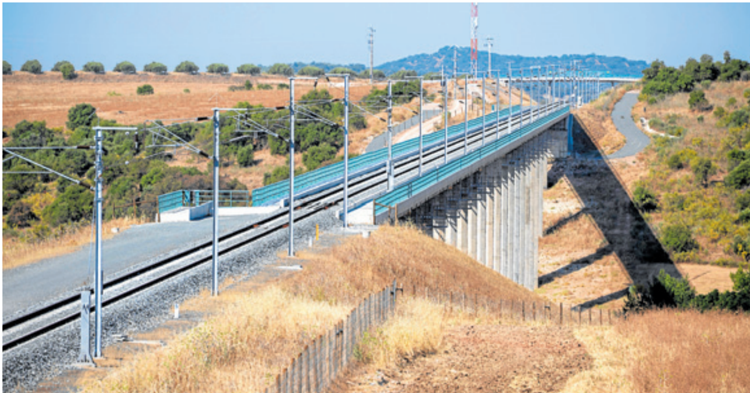
Uno de los viaductos que ha habido que construir entre Elvas y Évora. JOSÉ VICENTE ARNELAS
