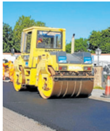
Arreglo de una carretera. HOY
