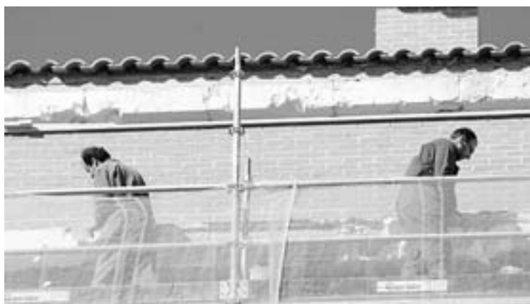
OBRAS. Concentran el 30% de los accidentes. / MARISA NÚÑEZ
