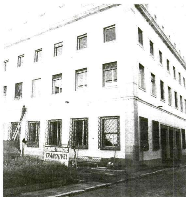
DELEGACIÓN. Las obras están casi terminadas. / E. PIÑERO
