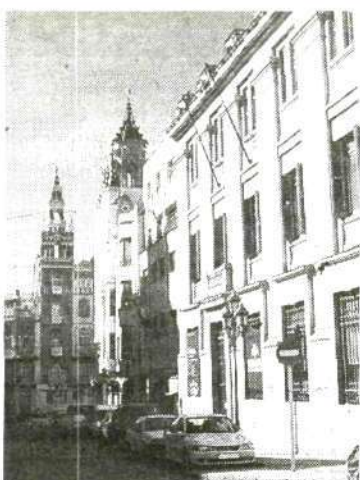
COMIENZAN LAS OBRAS. Del nuevo Conservatorio. / E. PIÑERO
