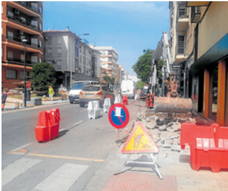
Inicio de los trabajos en la otra acera. M. A. M.
