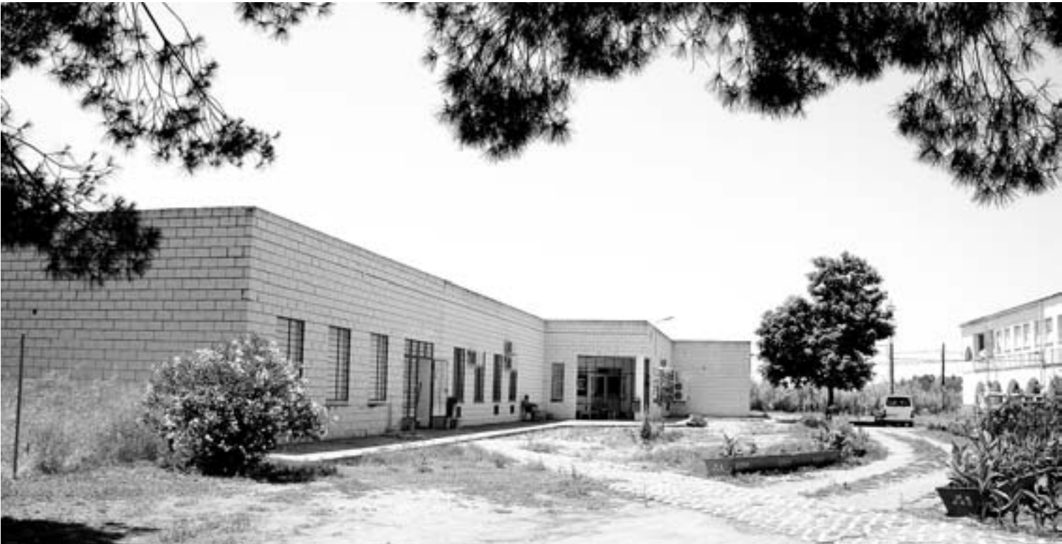
El Centro Hermano se encuentra junto a la antigua Escuela de Industriales, que será convertida en un centro de investigación el próximo año. / L. GARCÍA
