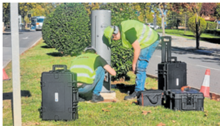
Colocación en noviembre de un radar en la avenida Emérita Augusta. HOY
