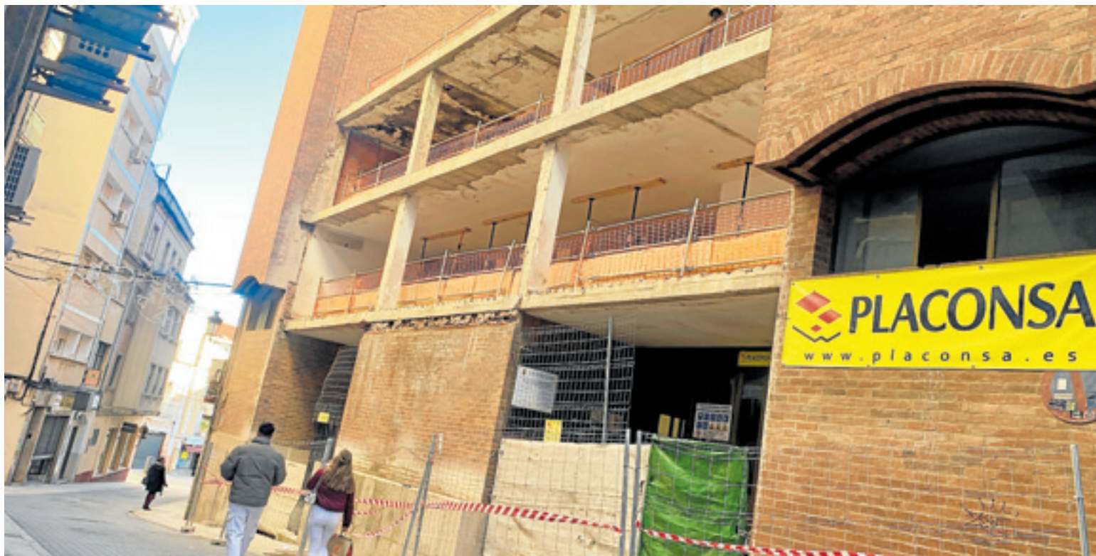
Así está la fachada de la futura sede de la Fundación Atrio, que albergará en su interior un auditorio con capacidad para 400 personas. M. J. T.
