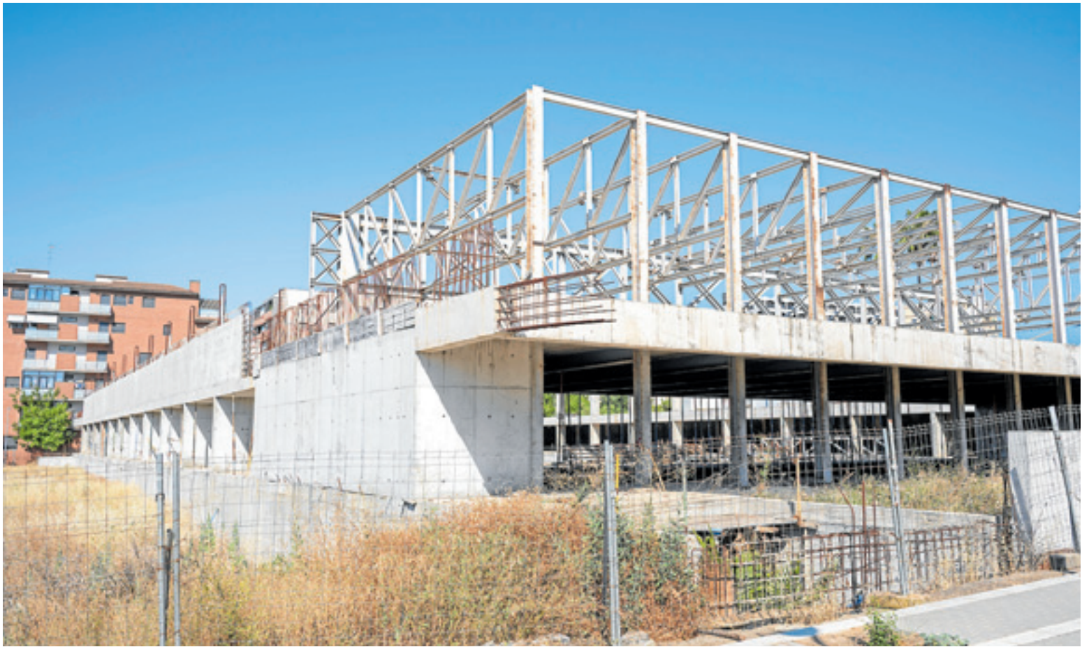
Obras paralizadas en la piscina de la margen derecha, que será reactivada en los próximos meses.. J. V. ARNELAS
