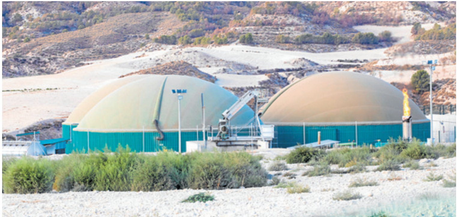
Una planta de biometano en la localidad murciana de Lorca. R. C.
