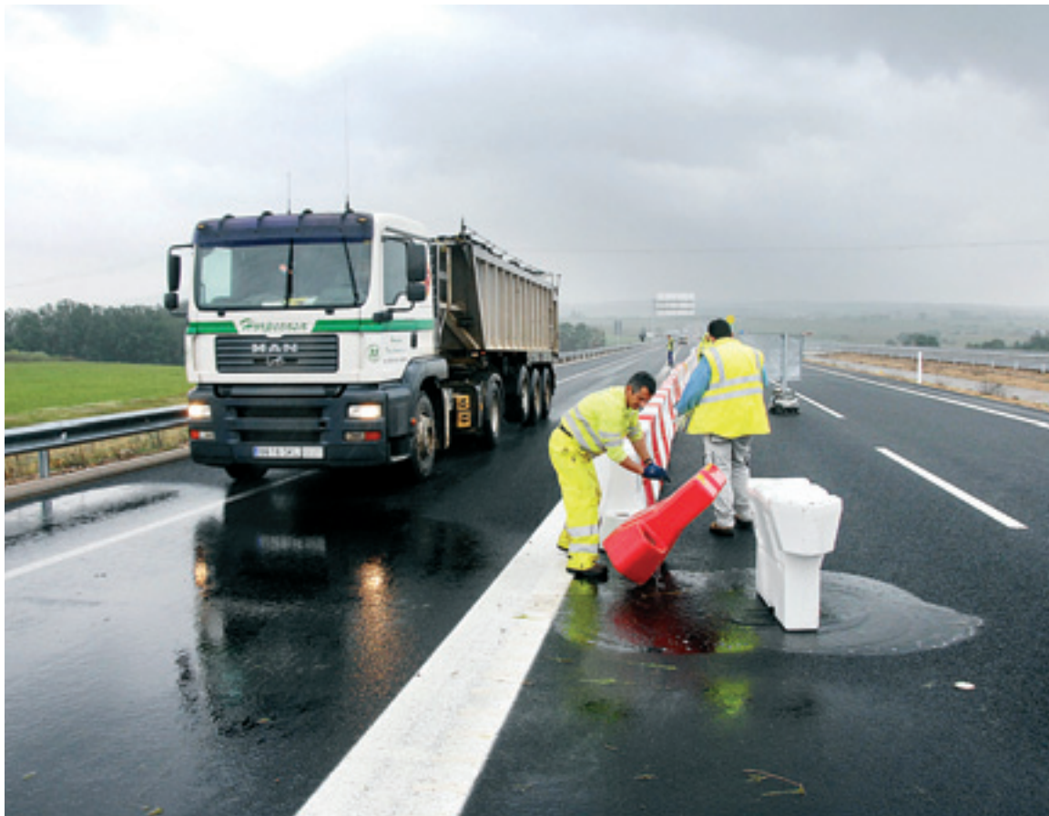
Los operarios dan los últimos retoques antes de que la vía entre en servicio. :: PALMA
