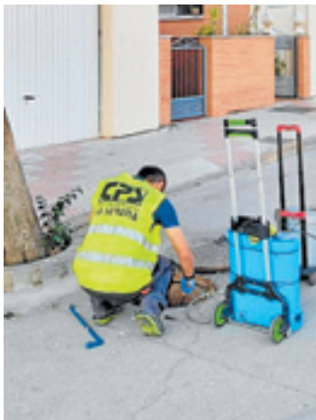
Trabajos en la red. F. V.
