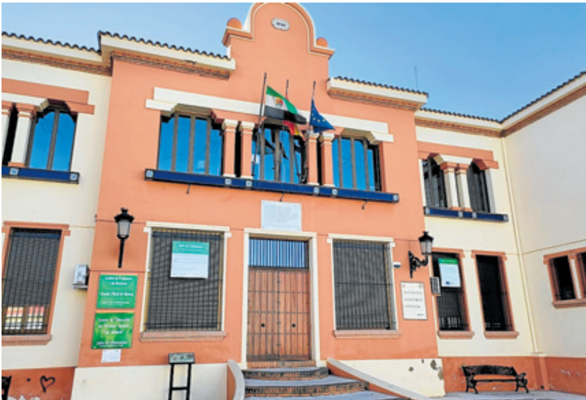
Fachada de la Escuela Oficial de Idiomas, donde se han instalado las redes denunciadas. P. G.
