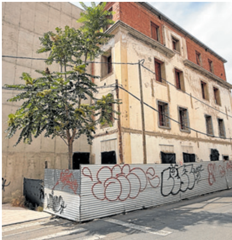
Aspecto actual de la fachada lateral de los pabellones militares. J. C. R.
