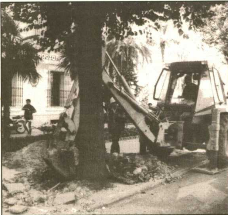
Derribo con excavadora de uno de los árboles. (ALFONSO)
