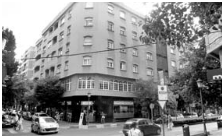
La casa de citas está en la calle San Pedro de Alcántara. :: GUINEA
