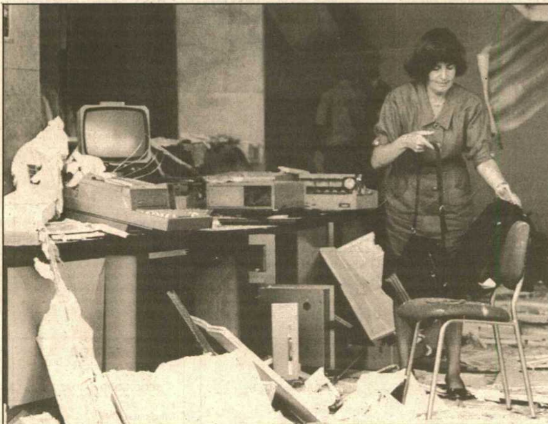
La bomba de los "grapos" destruyó la Jefatura de Tráfico de Gijón. (EFE)
