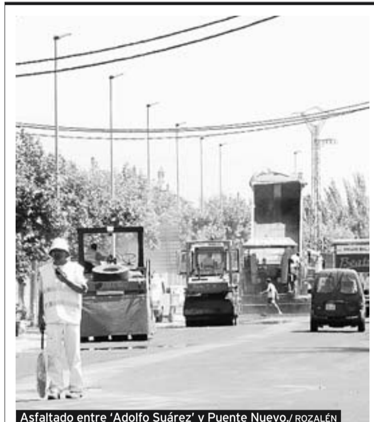
Asfaltado entre 'Adolfo Suárez' y Puente Nuevo./ ROZALÉN
