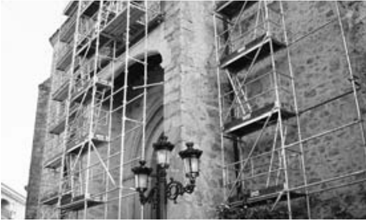
Andamiaje colocado en la fachada de la iglesia. / P. D. CRUZ
