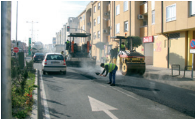
Los operarios realizan las obras de reparación. ■ J.R.N.G.
