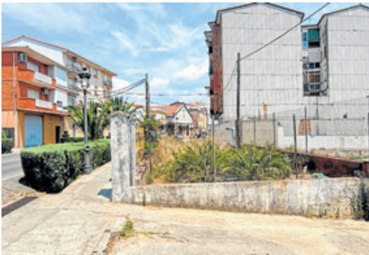
Los terrenos vallados, anexos a la antigua subestación. M. D. CRUZ
