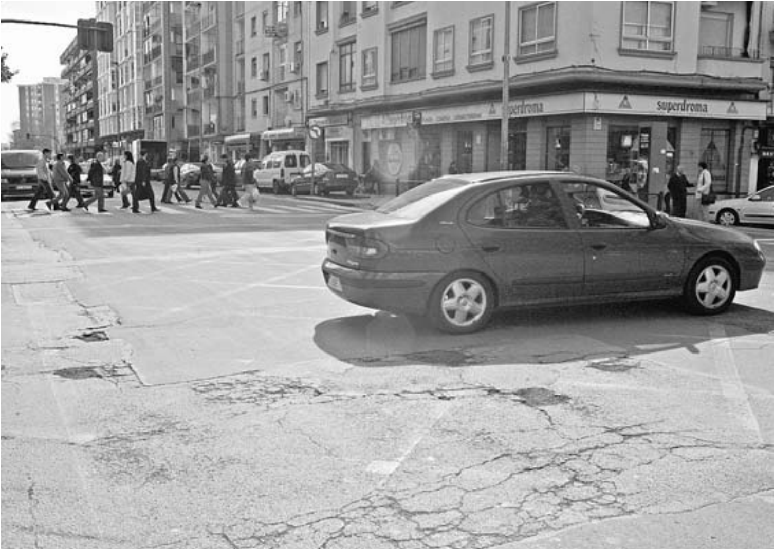
Cruce ente la plaza de América y la avenida de Antonio Hurtado, uno de los lugares con el firme más deteriorado. / LORENZO CORDERO
