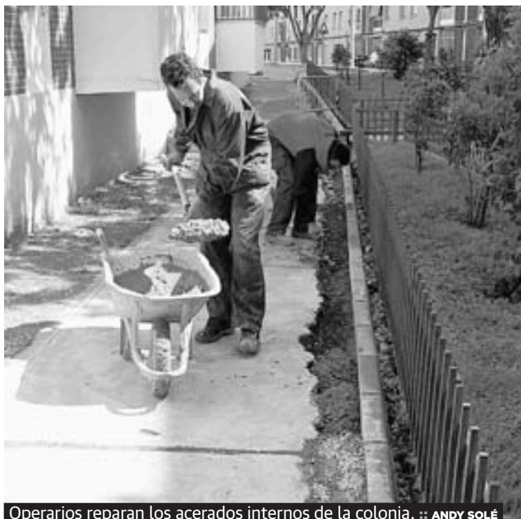
Operarios reparan los Acerados internos de la colonia. :: ANDY SOLÉ
