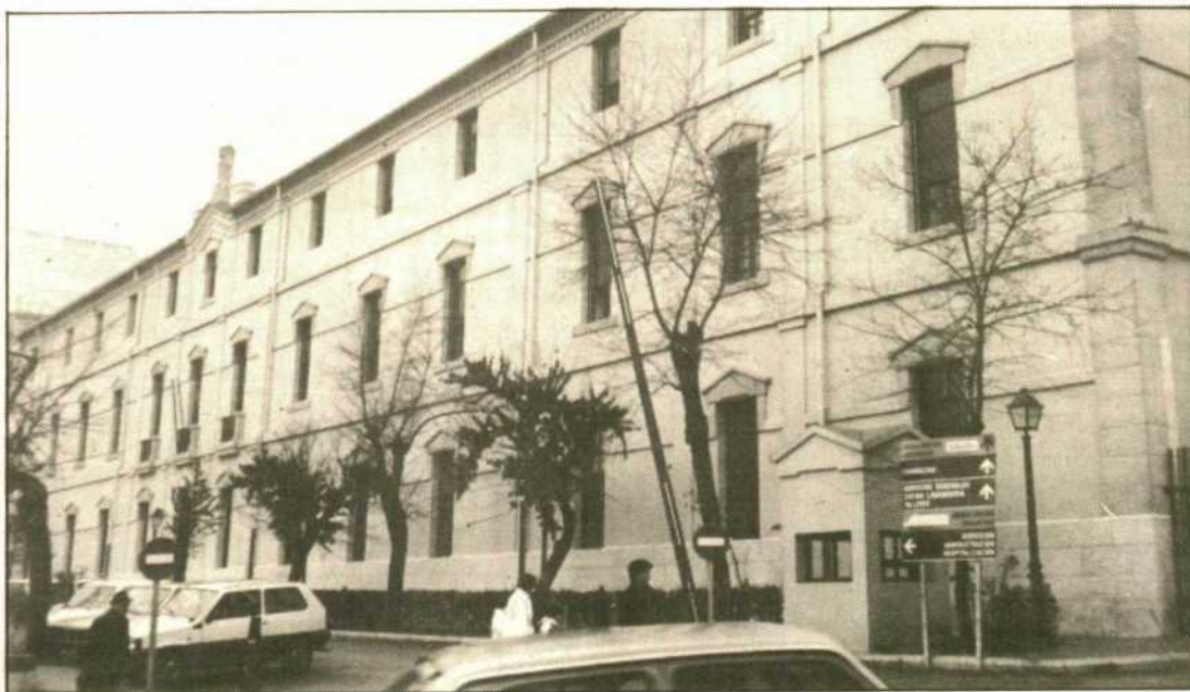
Hospital Provincial de Cáceres.
