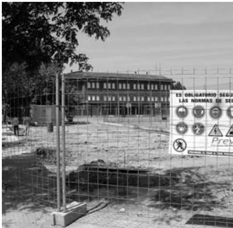
El Pozón ha sido el último centro en comenzar las obras. •• MAM
