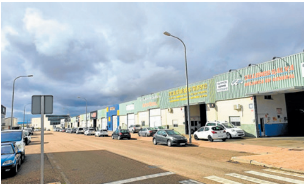
El crédito permitirá una gran inversión en el asfaltado de algunas vías del polígono industrial. P. G.
