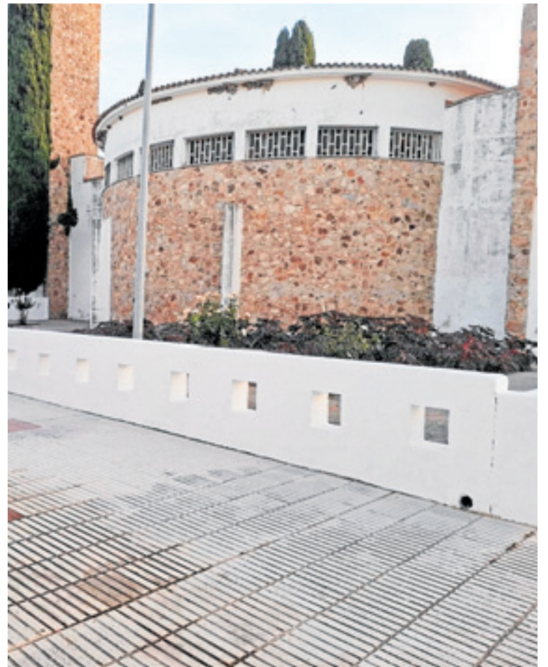
Adecuación y pintura de los edificios públicos. A. A. O.
